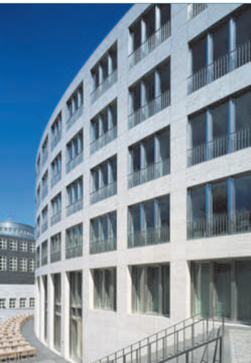
Der Blick vom Bürogebäude zum Museumstrakt führt über die Freifläche, welche auch von der Cafeteria genutzt wird.
